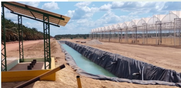
Figura 8: Bioevaporação e compostagem
